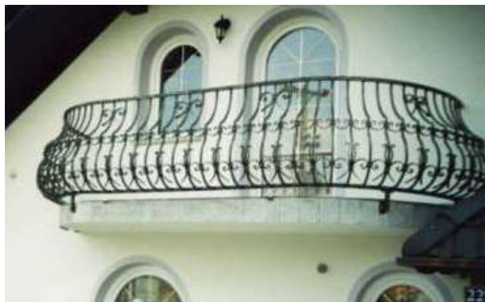
Sl. 2. Prikaz realizovane balkonske ograde
