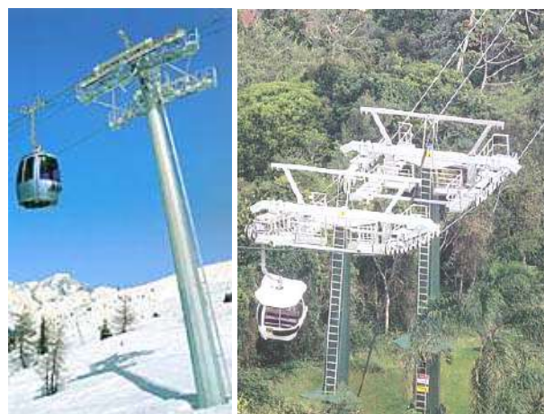
Сл.4. Стуб са позитивном и негативном котурном батеријом
